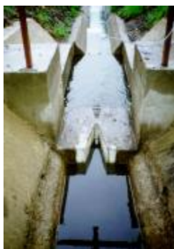
Pomiar przepływu w kanale otwartym
