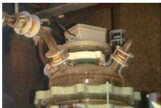
Pomiar poziomu różnych chemikaliów w zakładzie farmaceutycznym
